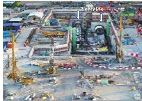
(d) Launching of shields
