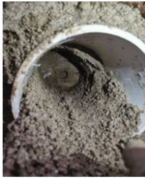
(d) Fourth excavation
